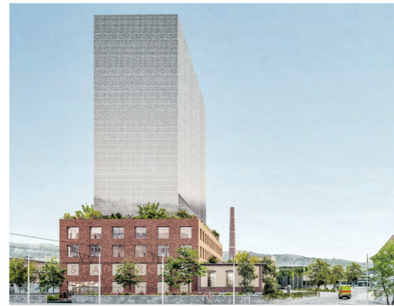
Photovoltaikkraftwerk auf Backsteinsockel
